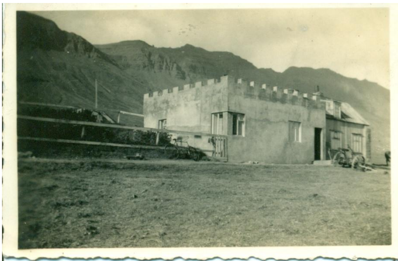
Nýbyggt steinhús, svokallað kastalahús, á Hofi í Norðfirði. Seinna var byggt ofan á húsið, en samkvæmt Sveitum og jörðum í Múlaþingi er það byggt á árabílinu 1934-1944. Ljósmyndari er óþekktur en myndin kom frá Jónasi Jónassyni frá Kolmúla.
